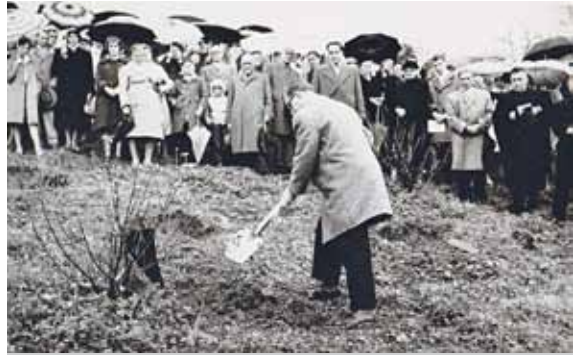
1. Spatenstich durch Pfarrer Fritz Joecks am 08.11.1960
